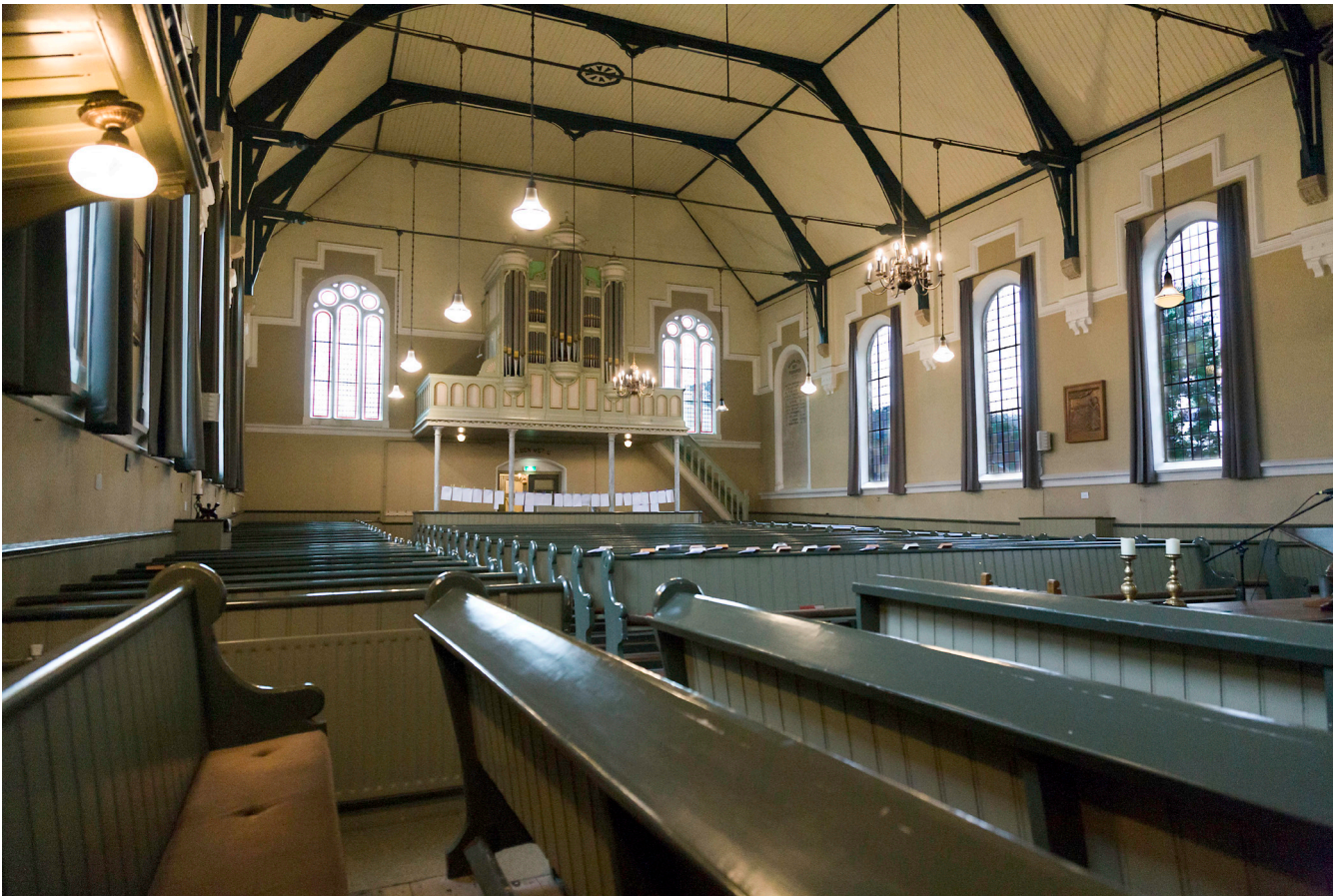
Interieur van de afgebrande kerk met zicht op het orgel.
